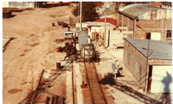
Figura 1. Registro histórico de autoclave en la antigua planta de impregnación de Montevideo.
